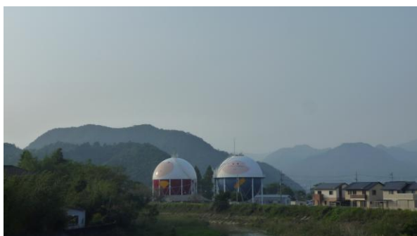
壁外調查看到的可愛水塔。
